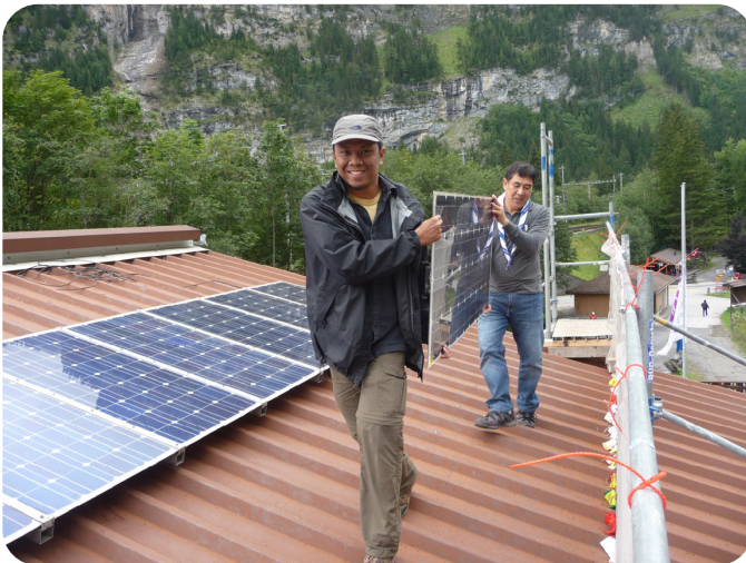
Instalação de sistema fotovoltaico
