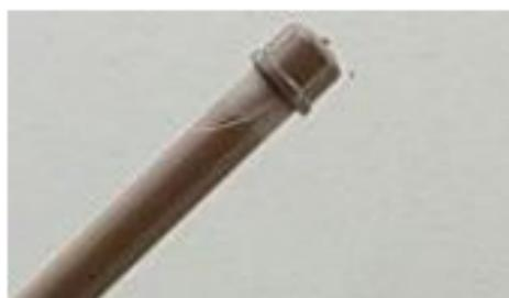
o Passe a fita isolante em torno da bobina, inclusive nos furos. Obs: Não bloqueie nem feche a extremidade inferior do tubo. Isto é para permitir a drenagem da condensação
